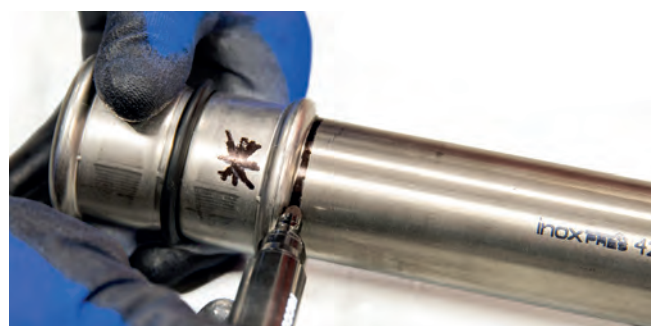
Afbeelding 32 – De inbrengdiepte markeren met behulp van een fitting
