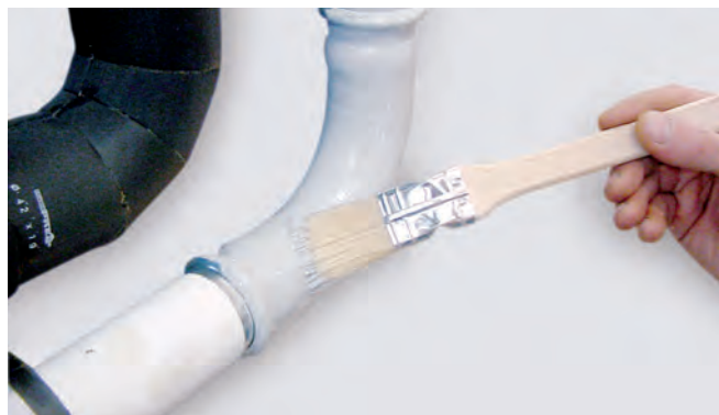
Afbeelding 42 – Het lakken van de verbindingen en buizen met primer.
